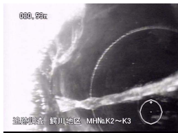
写真11 管口部側視状況 (本管のみ更生)
