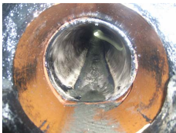
写真8 本管管口部の既設管露出
