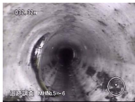
写真 4 管内状況 (本管取付管一体化更生)
