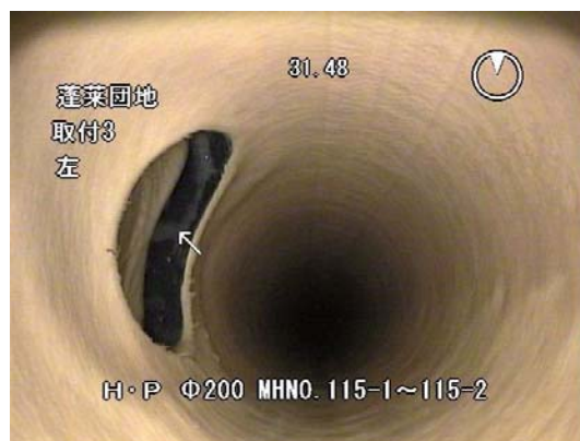
写真 2 管内状況 (本管取付管一体化更生)
